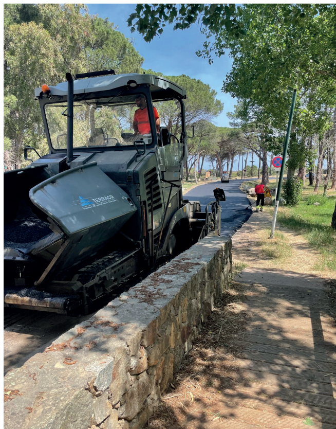
La réfection de la Route de la Pinède.
